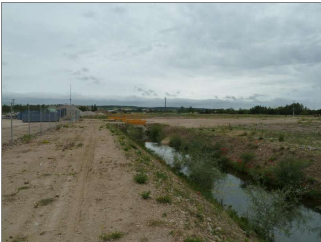
Fotografía A-6. Aspecto del desvío del arroyo de Los Prados.
