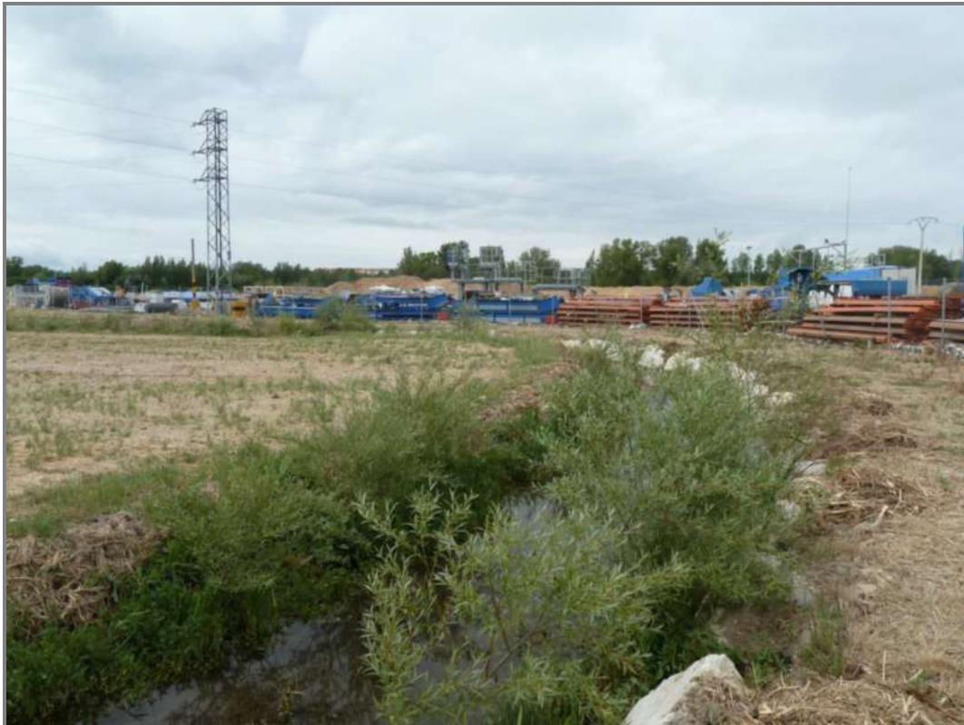
Fotografía A-5. Aspecto del desvío del arroyo de Los Prados.
