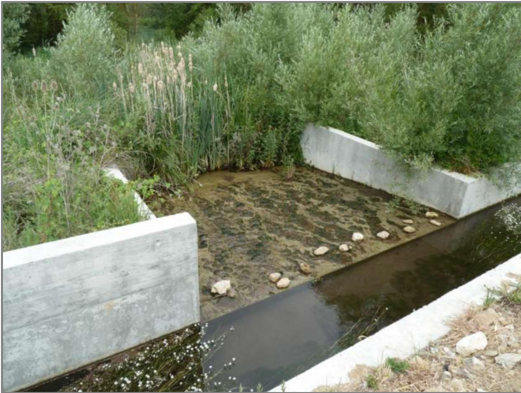
Fotografía A-11. Punto de desagüe de cauce molinar.
