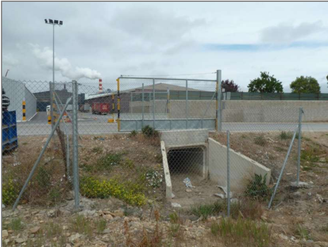
Fotografía A-1. Acceso de vehículos de transporte de mercancías.
